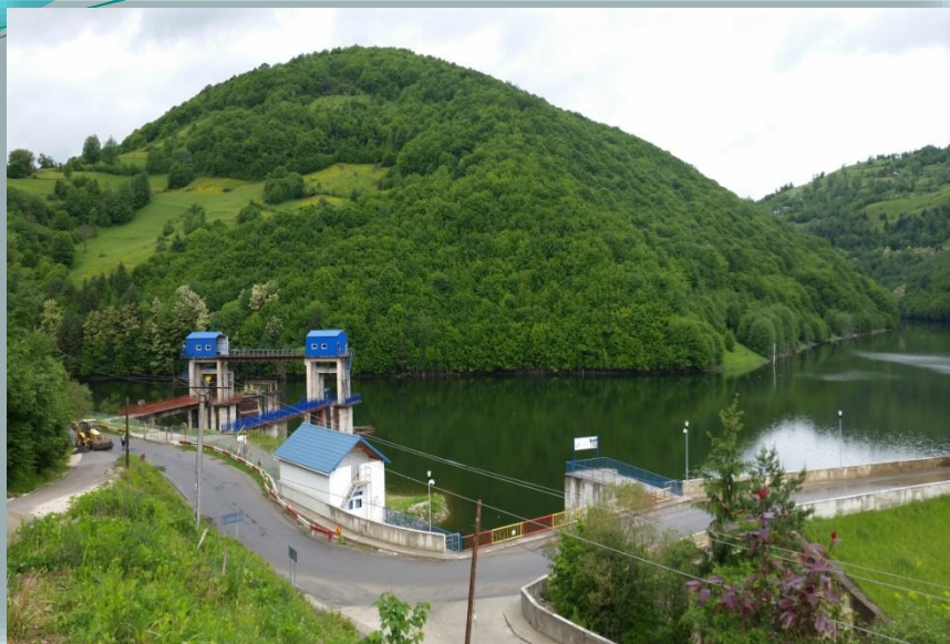
Vedere de pe baraj
