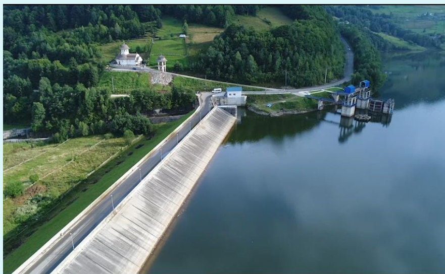
Paramentul amonte al barajului si parapetul sparge val
