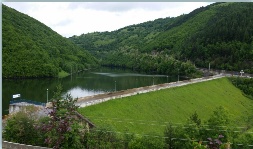
Lacul de acumulare-coronamentul barajului carosabil
